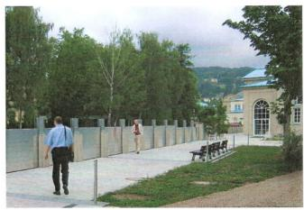
Der errichtete Hochwasserschutz bewahrt die Innenstadt vor Schäden bei einem hundertjährlichen Hochwasserereignis unter Berücksichtigung eines durchgehenden Freibords von einem Meter Höhe entlang der gresamten Schutzlinie.
